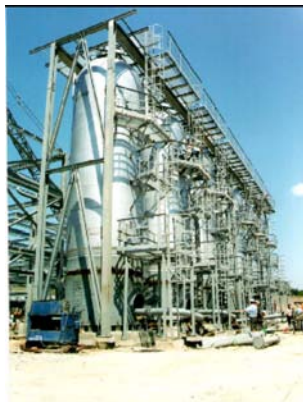
Монтаж установки под- готовки газа на КС Крас- нодарская газопровода «Голубой поток» 2002 год
