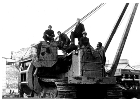
Студенты осваивают импортную трубоукладочную технику 1982 г.
