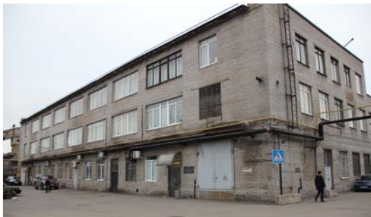
Здание в промзоне на Витебском проспекте в Санкт-Петербурге, где сейчас ОАО «СПбЗНИИПИ»
